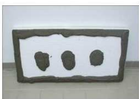
Obrázek 1: Správné nanesení lepící hmoty na desky EPS
